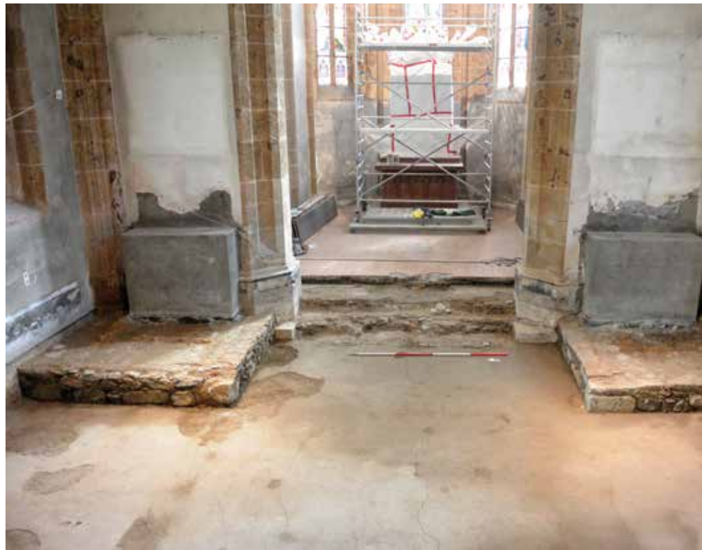
Bei den Renovierungsarbeiten wurde der alte Boden freigelegt.
